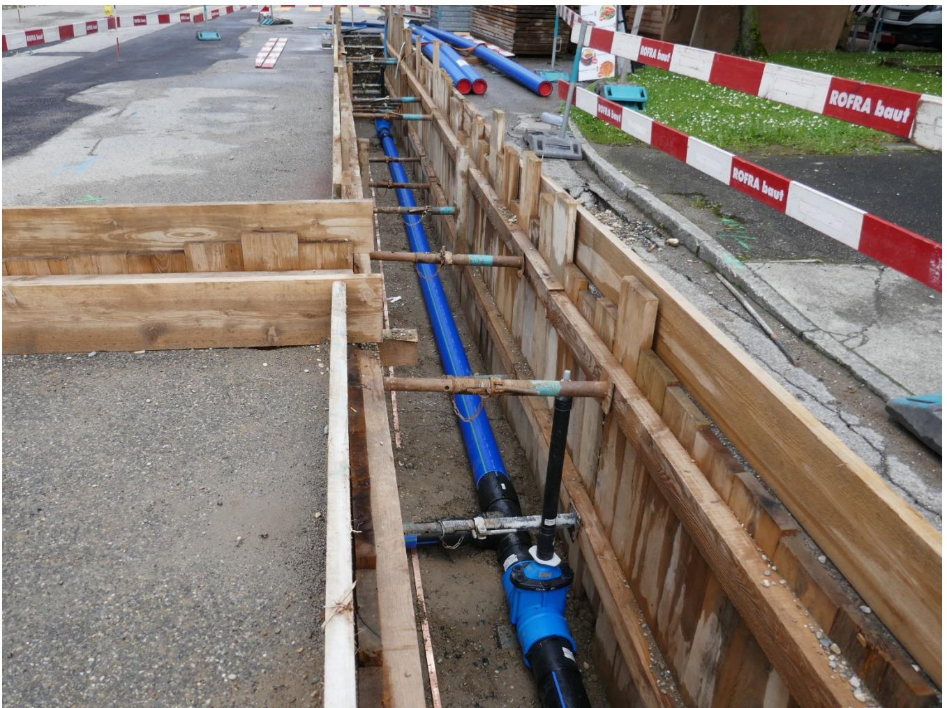
Abb. 13: Leitungsgraben Hofackerstrasse mit Erdungsband
