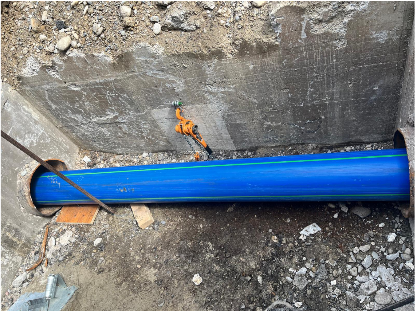
Abb. 14 Zielgrube Birsfelderstrasse (Einzug in alte DN 500 Gussleitung)
