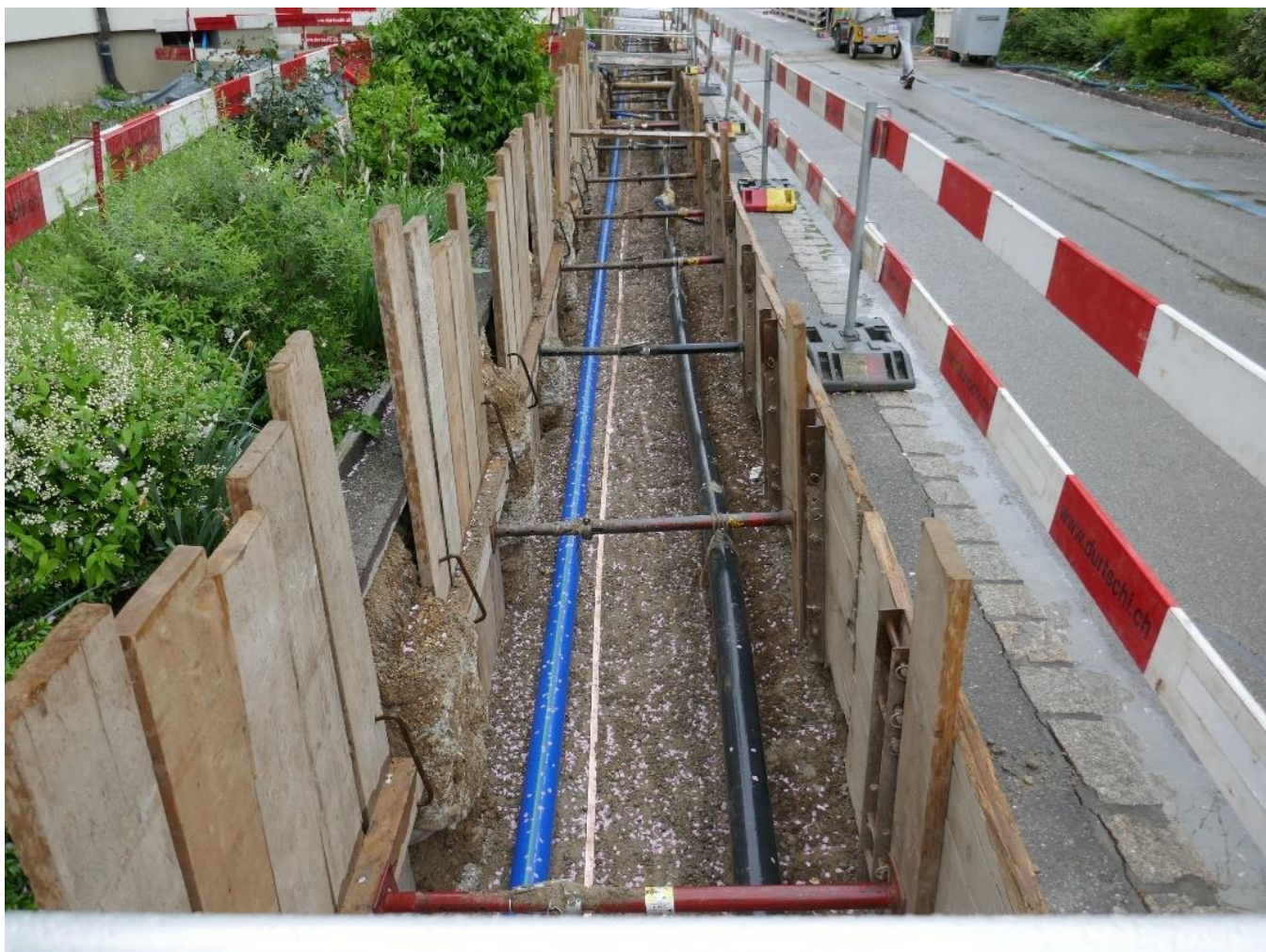
Abb. 14: Leitungsgraben Genossenschaftsstrasse mit Erdungsband
