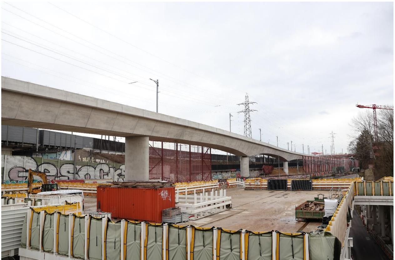
*Auf der Donnerbaumbrücke sind die neu montierten Fahrleitungsmasten erkennbar.*
