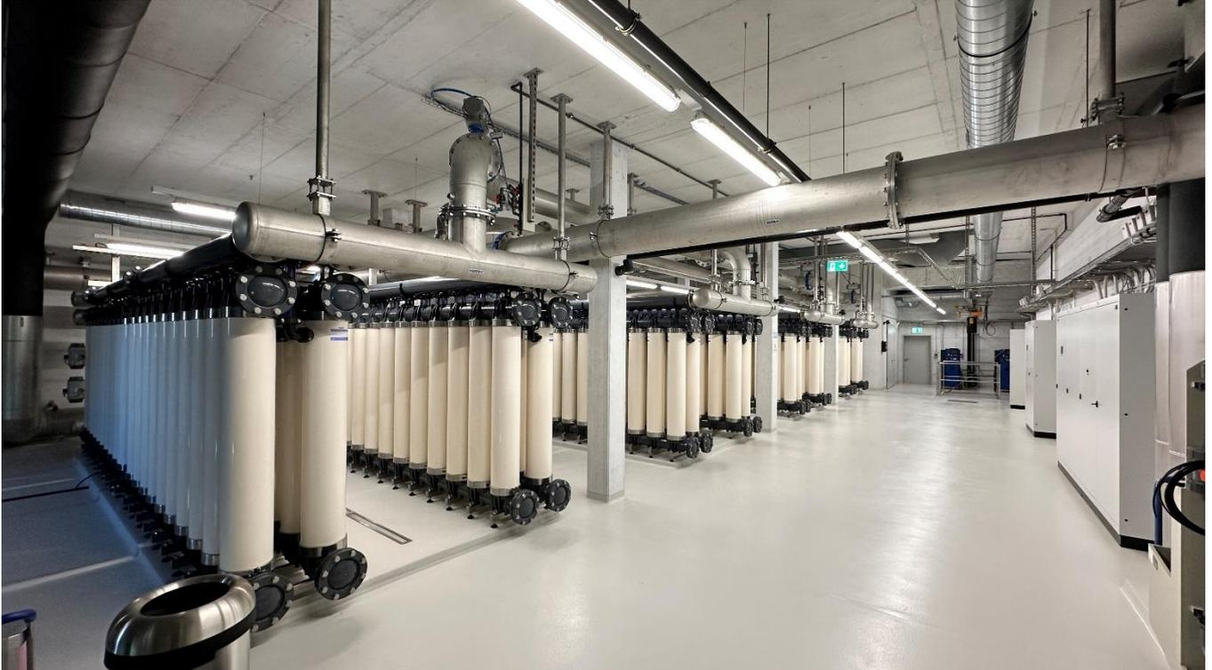
Abb. 9: Die Ultrafiltrations-Stufe der TWA. Hier wird die zuvor zugesetzte Pulver-Aktivkohle wieder abgetrennt
