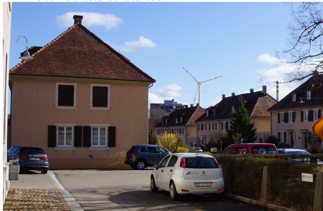
4 FM Freidorf Genossenschaftshaus
