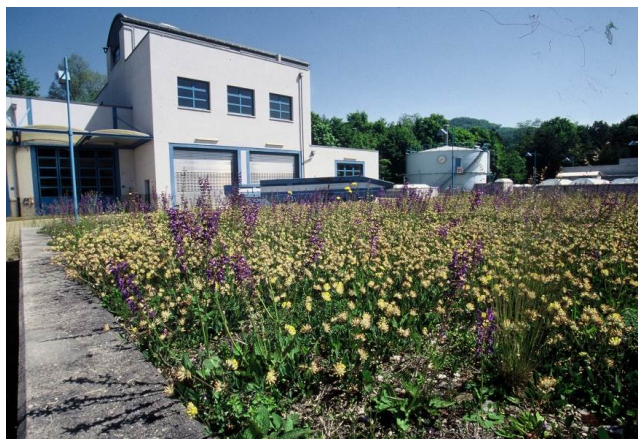
(Becken-)Dachbegrünung in der ARA Ergolz 2 in Sissach mit Halbtrockenwiese.
