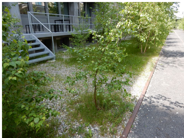
Begehbare Schotterrasen im Wechsel mit Verkehrsflächen.
