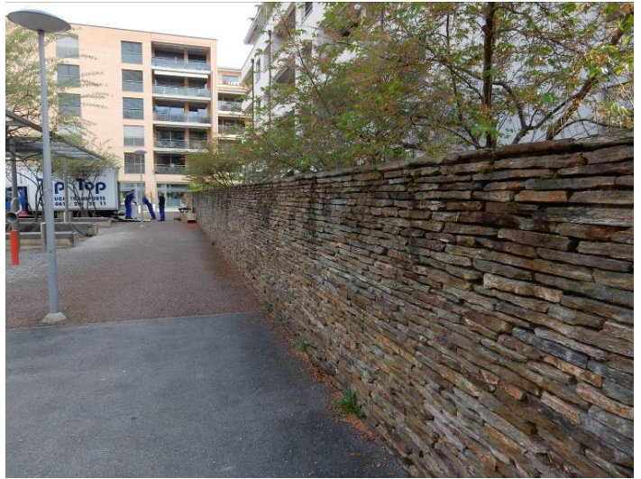
Nur innen gemörtelte Mauer aus plattigen Steinen; Quartier Gundeldingen, Basel.
