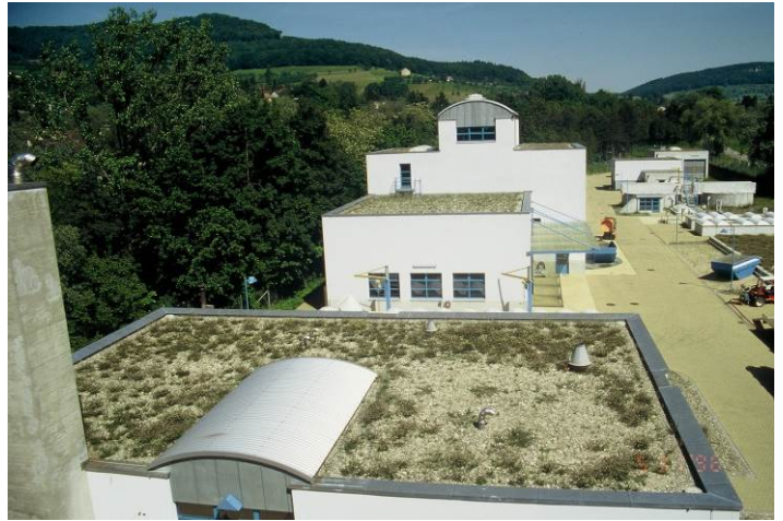
Extensive Dachbegrünung mit anstehendem Material (Ergolzkies) in der ARA Sissach.
