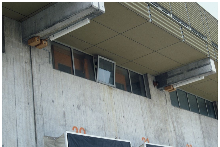
Nistkästen für Mauersegler an einer hohen Zweckbau-Fassade; Migros Suhr, AG.
