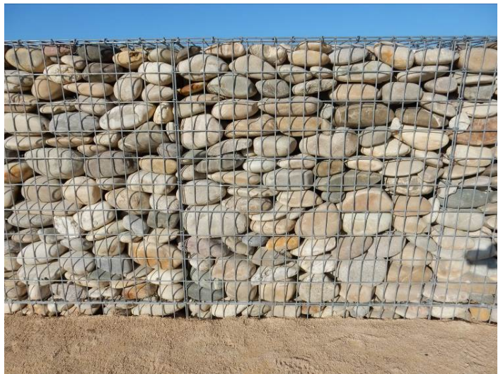
Drahtschotterkörbe mit Bollensteinen aus dem Rhein als Parkabgrenzung; Ile du Rhin bei Märkt, F/D.
