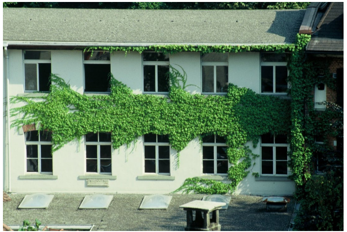
Efeu ist selbstklimmend, immergrün und kann 30 m hoch klettern. Voraussetzung für eine Fassadenbegrünung ohne Probleme sind eine intakte Aussenhaut und Zugänglichkeit bezüglich Rückschnitt.
