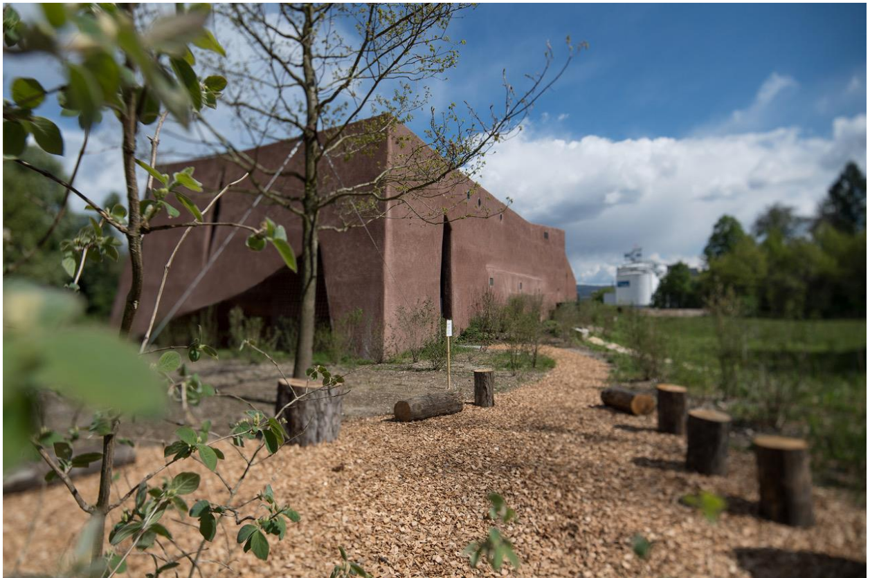
Trinkwasseraufbereitungsanlage Obere Hard, Muttenz
