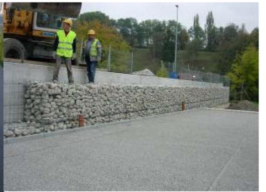
Eine Anschüttung mit Steinen auf der Rückseite und ein Steinkorb auf der Vorderseite sorgen an dieser Mauer für eine gewisse Durchlässigkeit für Kleintiere (Foto: M. Trocmé)
