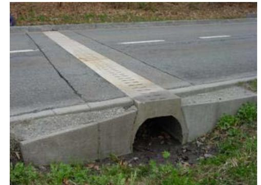
Aco-System: Wenn aus technischen Gründen nicht tief gegraben werden kann, so ist diese Methode oft die einzig mögliche Lösung (ASTRA 2014 / www.aco-pro.de).
