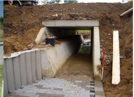
Beispiel für Kleintierdurchlass, der parallel zu Fussgänger-Unterführung geführt wird (www.tiefbau-system-technik.de).
