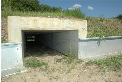
Beispiel für Kleintierdurchlass (www.nbe-betonwerk.de).
